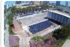
Carregador de EV
